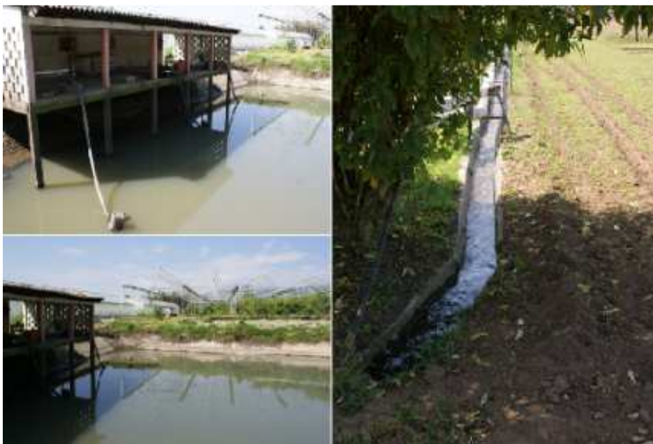
Figure 19 : Bassins de stockage de l'eau et canaux de distribution pour l'irrigation des serres Source: (Imbernon, Travail de terrain 2012)
